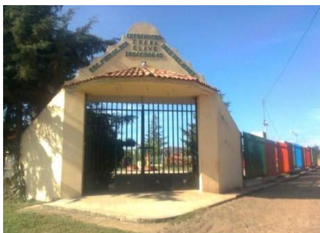
Foto 14: Fachada de la escuela
